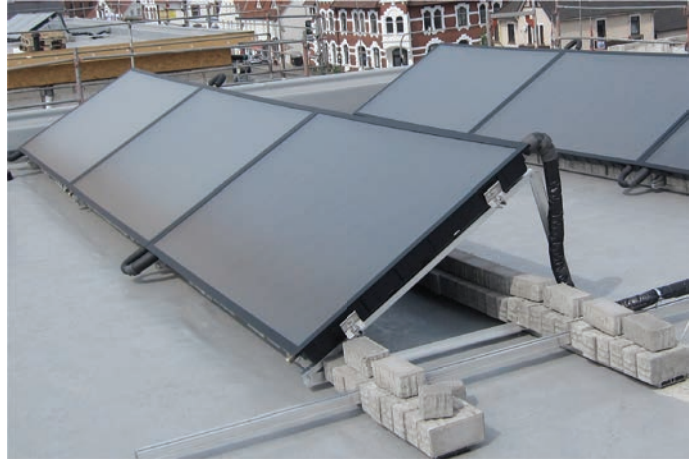
Abb.: CAPITO Solaranlage mit 6 Flachkollektoren CC PCW 252
