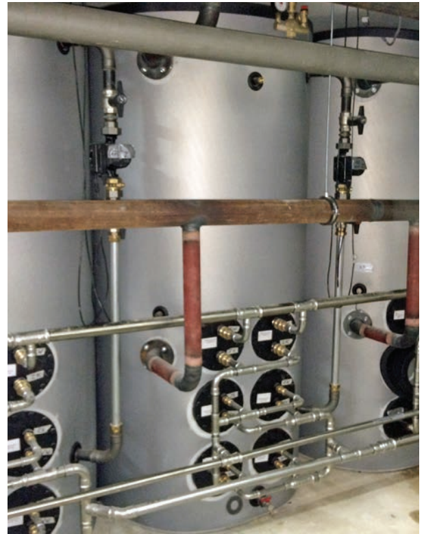
Abb.: Trinkwasseranlage mit 3 CAPITO Pufferspeicher 2-Zonen-PD 750
