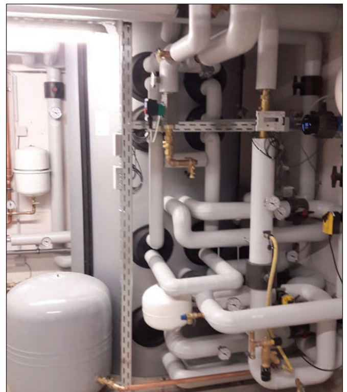
Abb.: Anlage mit CAPITO Wärmepumpenspeicher
