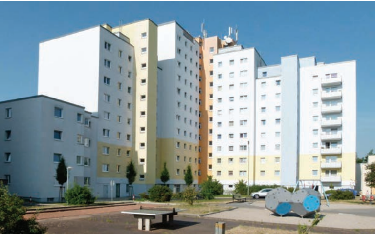
Abb.: Gebäudekomplex mit 101 Wohneinheiten in Würzburg
